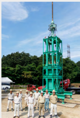
▲杭の急速載荷試験の載荷装置
